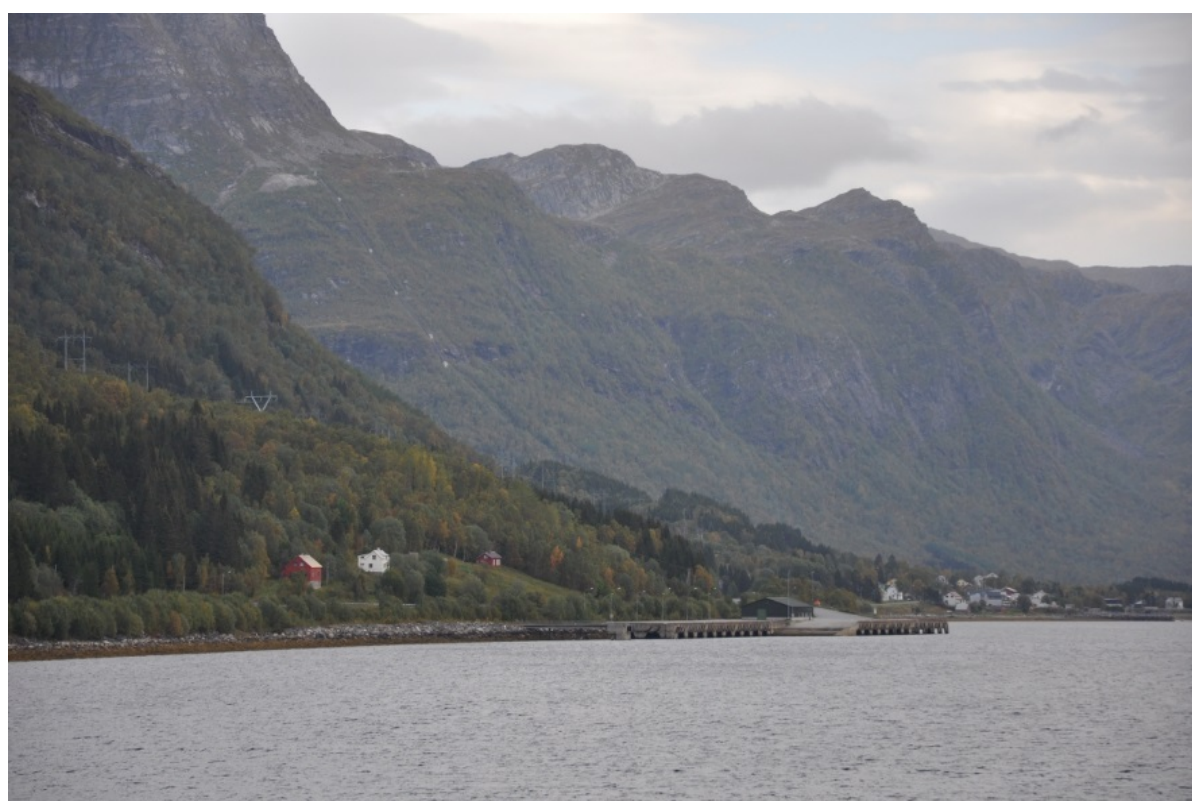
Figur 3: Stortinden i øvre venstre billedkant. Bildet viser Natokai sett fra Dragvikområdet mot Bogen. Kilde: Sweco
