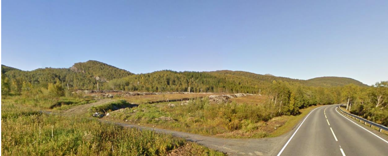
Figur 3: Sett fra vest mot øst ved Osvatnet. Dagens E10 og planområdet til vestre for dagens veg.
