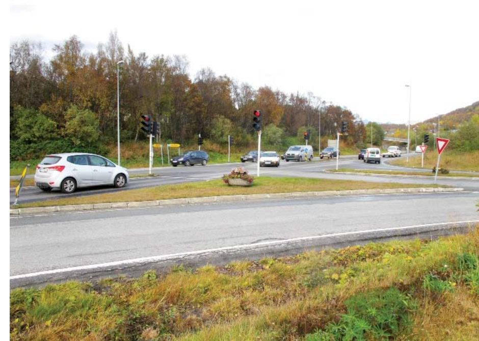
Krysset i Kanebogen (A3 på kartet) vil bli oppgradert blant annet med ny rundkjøring, og god tilrettelegging for myke trafikanter, med sykkelveg med fortau, samt planfri kryssing av veg.
