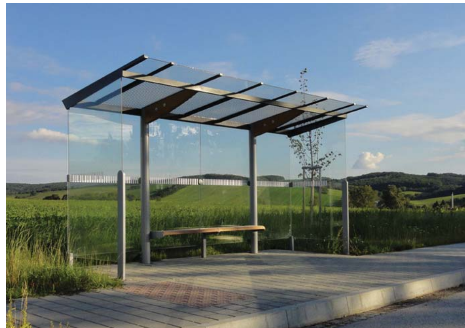
Leskuret på bildet har en utforming som tilsvarer ønsket uttrykk.
