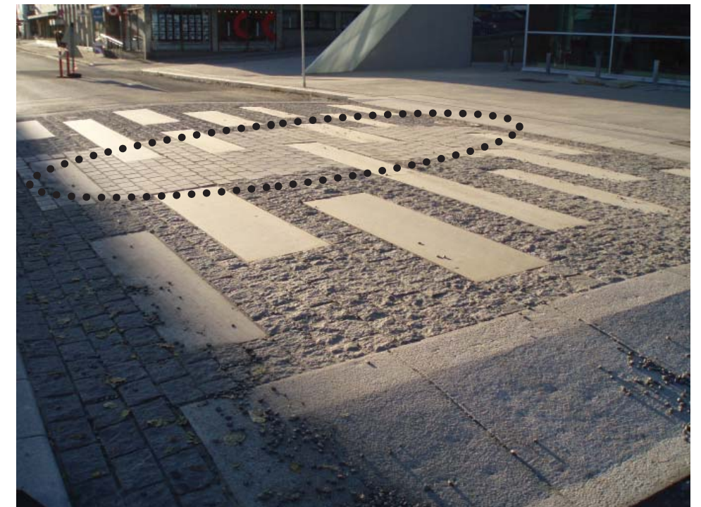
Innringet på bildet ser man at et jevnere belegg er integrert i designet. Det er mer behagelig å gå på, og gjør overgangen tilgjengelig for alle.
