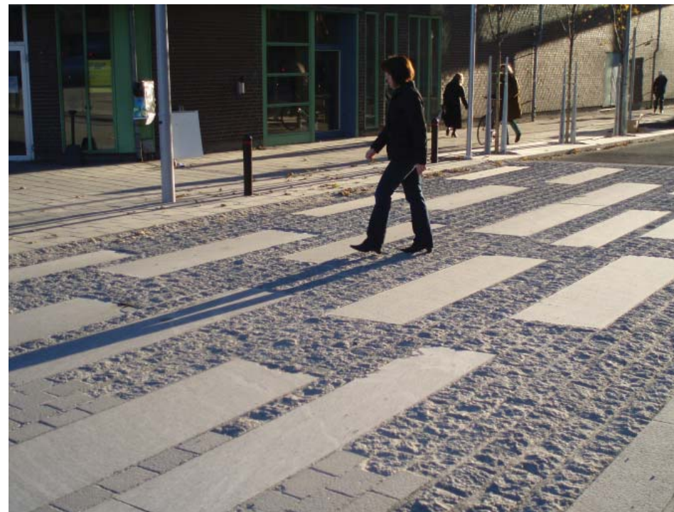
Gangfelt i Grønnegata i Tromsø. Her er feltet både opphøyd, og en god del bredere enn vanlige opphøyde gangfelt. Belegget er ujevnt å kjøre på, og innbyr til lavere fart. Utformingen bidrar til å omdefinere vegen til gate, og høyner kvaliteten på uterommet. Overgangen har et område med jevnere belegg, som er mer behagelig å trille/gå over.
