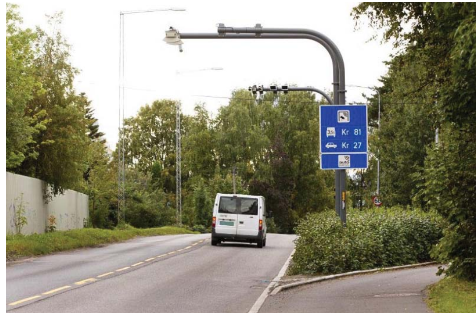
Bomstasjon i Sørkedalsvegen i Oslo. Her har man brukt vegetasjon bevisst for å redusere inntrykket av bomstasjonen.
