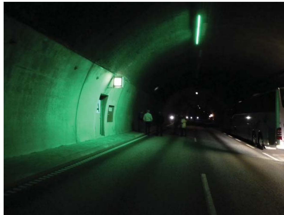
Tydelig markering av rømningsvei
