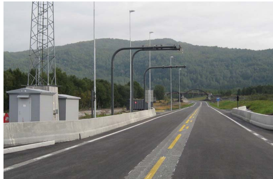
Bomstasjoner i Harstad skal ikke fremstå som dette eksemplet fra Godøystraumen. De tekniske byggene og rekkverket tilfredstiller ikke ambisjonsnivået mht. visuell kvalitet. Betongrekkverk skal ikke benyttes.
