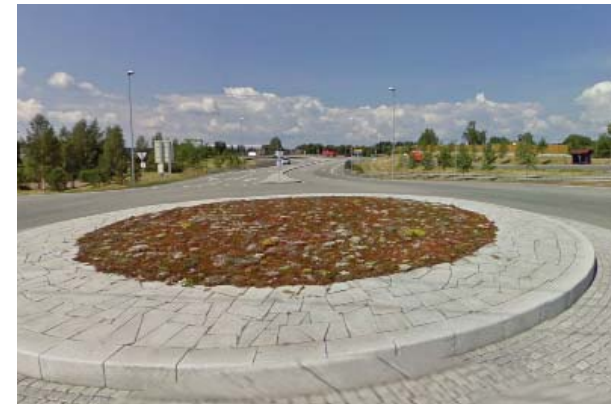
Sedum i rundkjøring på E16, Kongsvingerveien. Bør vurderes benyttet i store trafikkøyer og rabatter. NB: Føringer for rundkjøring er gitt som et eget punkt.
