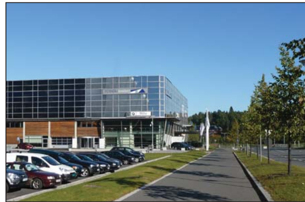
Rabatter med vegetasjon bidrar til å dele opp og dempe inntrykket av trafikkorridoren.
