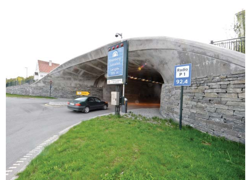
Kombinasjon av naturstein og betong ved Steinberg tunnelen i Trondheim.
