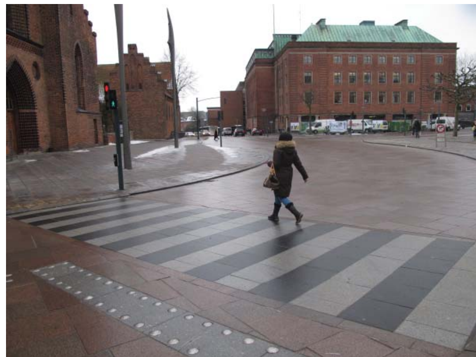
Eksempel på høy kvalitet i både kjørebane og overgang for fotgjengere. Utformingen innbyr til lavere fart, og bidrar til å gjøre vegen/gaten til en del av byrommet.
