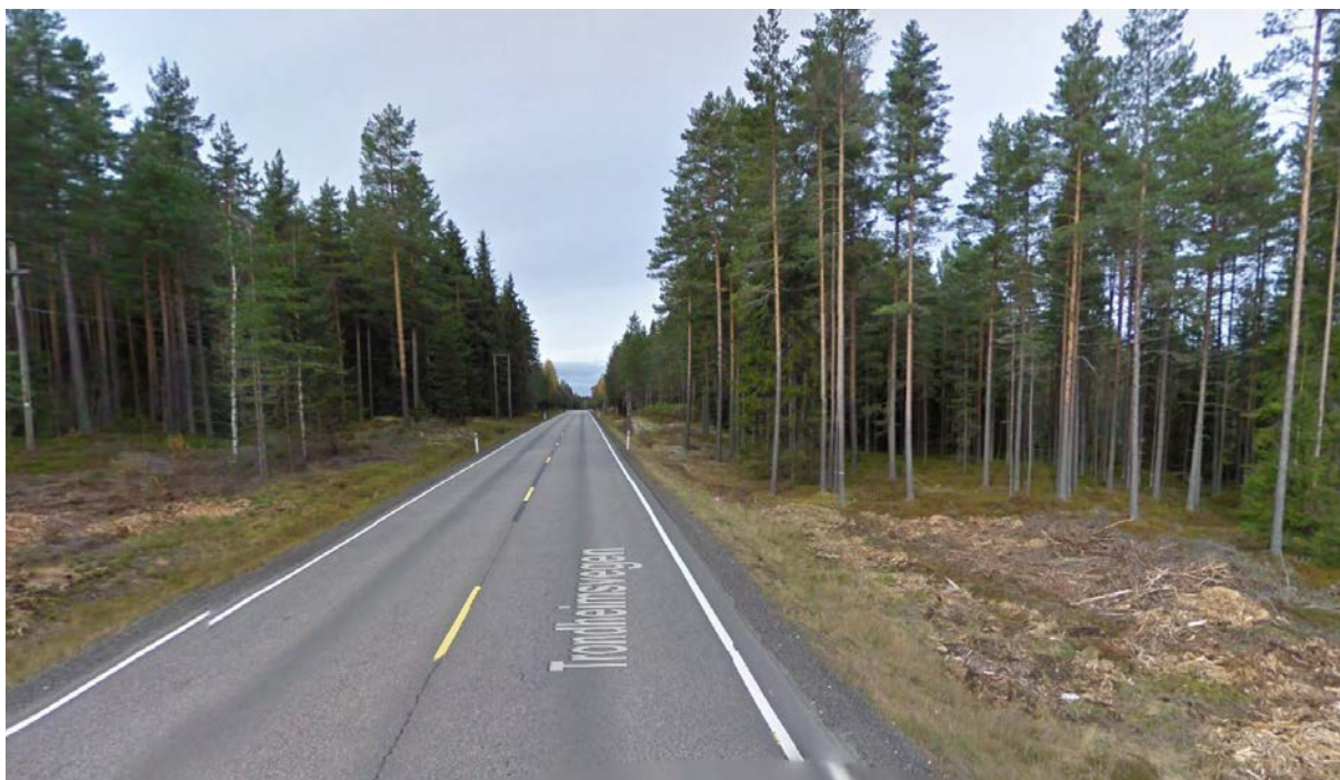
Over: Rv. 3 sett nordover, ca. midt i planområdet. Kilde: Google streetview.
