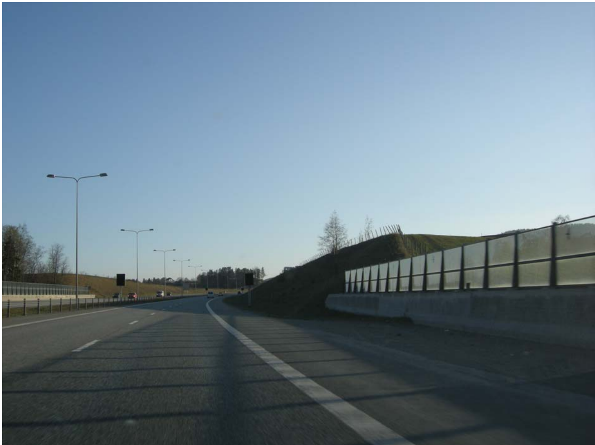
Figur 8 Utforming av støyskjerm på betongrekkverk - prinsipløsning
