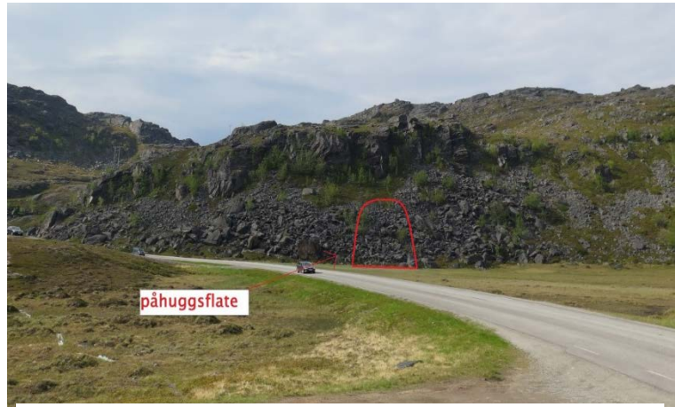
Figur 1 Søndre påhuggsflate. Foto: Hallvard Nordbrøden
