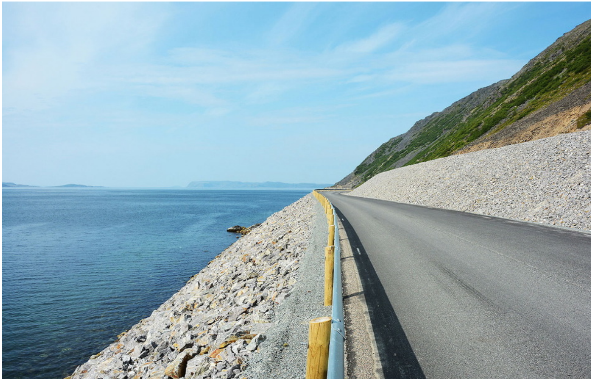
Permanent hylle over lengre strekning bør ha varierende høyde. Illustrasjon: Elisabet Kongsbakk
