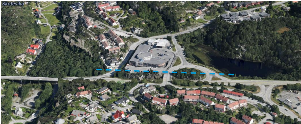
Figur 14: Ny kulvert for utløp fra Stiavatnet
