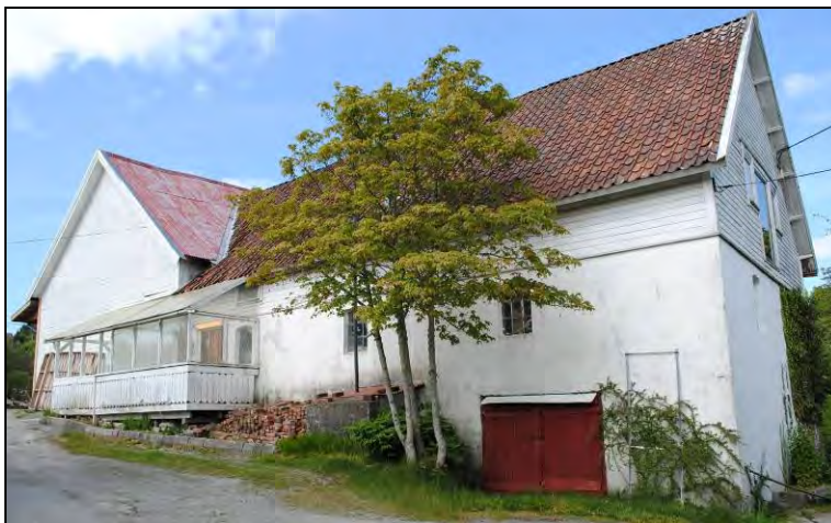
Figur 4-4. Driftsbygningen på Sørmarkveien.
