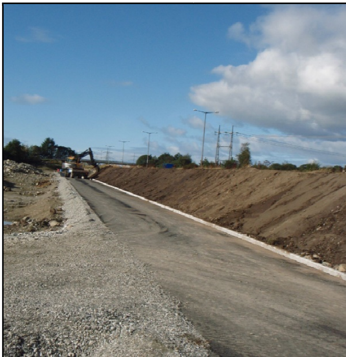
Bilde 1. Ca. 500 meter sykkelstamveg ferdig etablert med voll, på Forus. (Bilde: Multiconsult AS)
