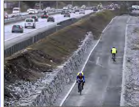
MOTORVEI: En bit av sykkelmotorveien mellom Stavanger og Sandnes.
