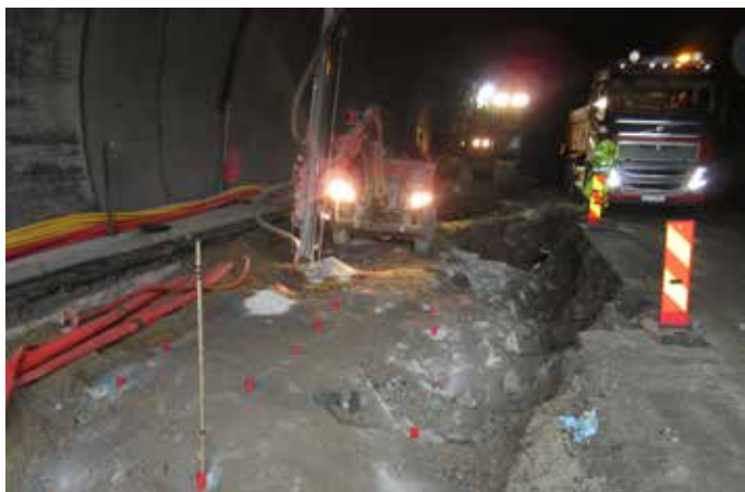
Slik så det ut i Austad-tunnelen bare dager etter stengingen. Det gjøres klar til sprengning. (Foto: Jonny Nedrejord)
