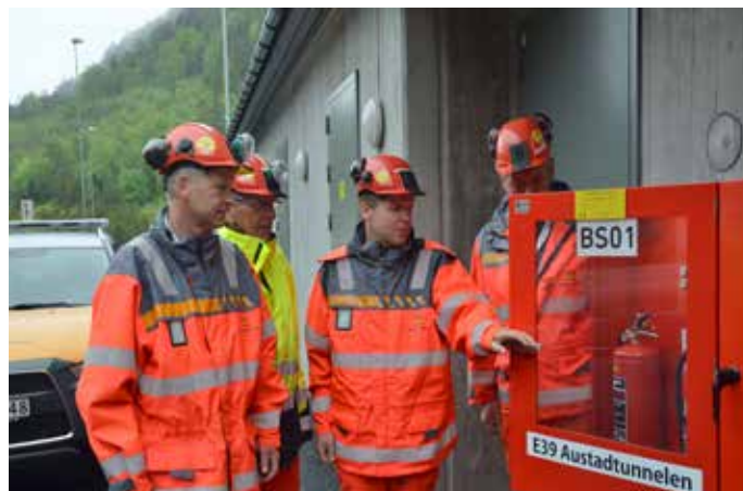
Det er bygd seks tekniske bygg i tilknytning til tunnelene. Her inspiseres skapet til brannsløkkeutstyret. (Foto: Jo Vegard Aardal)
